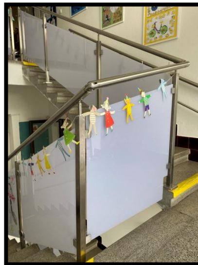
zábradlí po rekonstrukci
