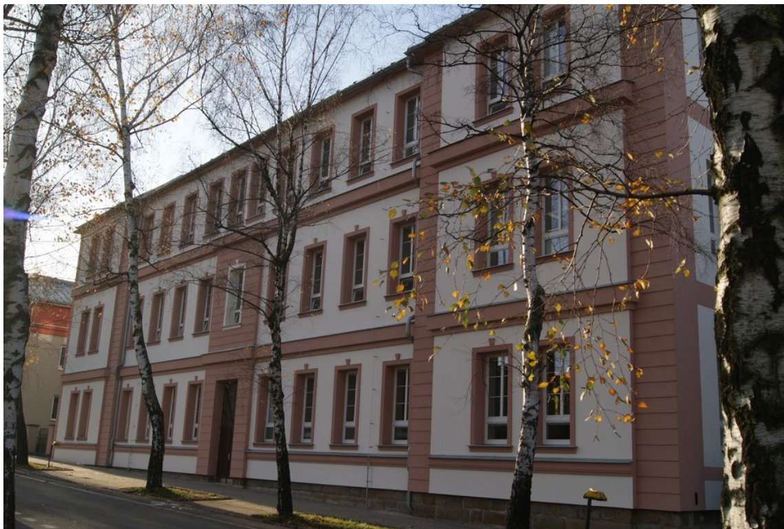
Příloha č. 1: ZŠ a MŠ Frenštát p. R., Tyršova 913 (čelní pohled)
