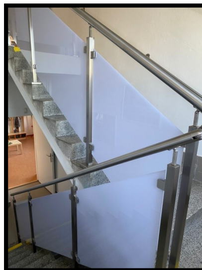
zábradlí po rekonstrukci
